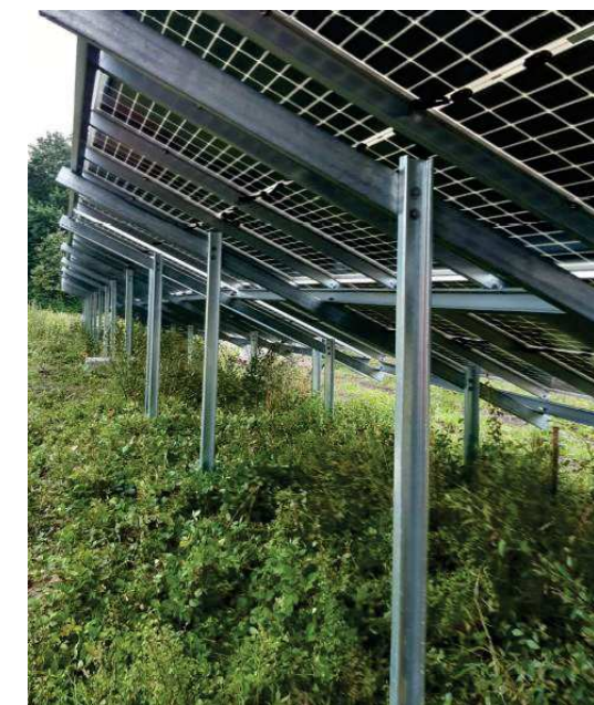
Photo 19 : ancrage des tables avec pieux acier
